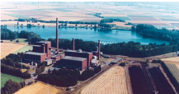
Das Blockheizkraftwerk mit seinen bis zu 100 Meter hohen Schornsteinen dominierte das Stadtbild Wölfersheims für Jahrzehnte.
